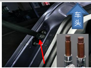
2.3 拆下原车左侧下支架:使用12角花M6头拆除支架螺丝
