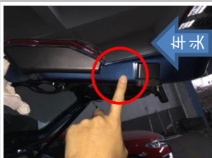
2.8 打 \Phi 19\text{mm} 孔走电机线 : 按如图中位置打孔走电机线 (右侧同样方法)
